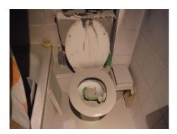
Das Bild zeigt eine erhebliche Verschmutzung durch den Einsatz eines Pulverlöschers bei einem kleineren Brand.
