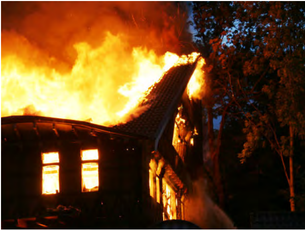
Abbildung 15: Einstürzende Giebelwand bei einem Dachstuhlbrand Quelle: Feuerwehr Bovenden
