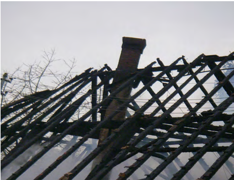
Abbildung 16: Schornstein kurz vor dem Einstürzen nach einem Dachstuhlbrand Quelle: Freiwillige Feuerwehr Laufenburg (Baden)
