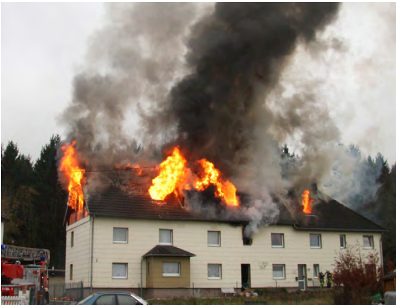
Abbildung 18: Erste Frontalansicht bei einem Dachstuhlbrand
